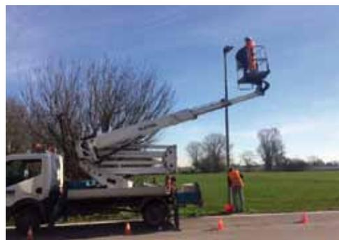
Sono iniziati a inizio marzo i lavori di riqualificazione della rete di pubblica illuminazione. La riqualificazione riguarderà una serie di interventi tra cui la sostituzione delle armature di 500 punti luci, di cui
