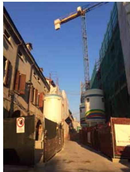
Cantiere in via della Pace
