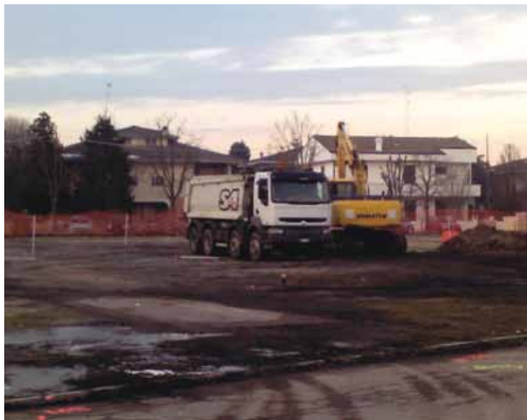
L'avvio dei lavori nell'area "parco fieri"
