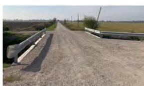
È stato completamente ricostruito il ponte sul canale Dugale II in via Valdisole, nella frazione di Fossa. L'intervento, realizzato nel 2021 con una spesa di 100mila €, si è reso necessario per rifare una struttura obsoleta e che è di fondamentale importanza per il passaggio dei mezzi agricoli.
